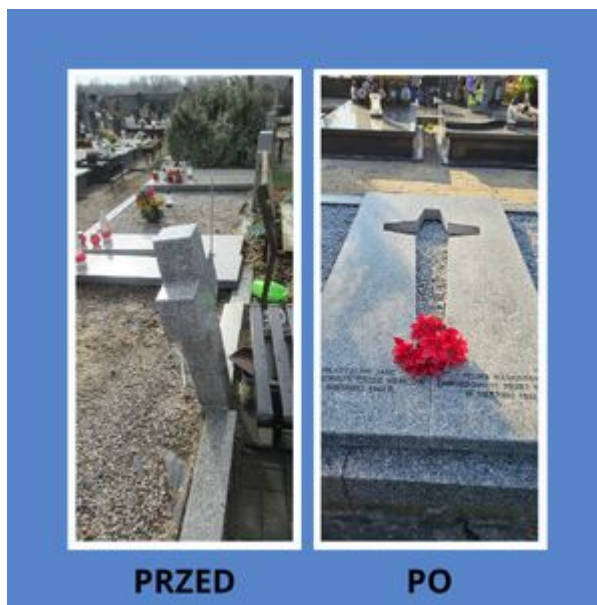
Remont mogiły w Nowym Dworze Maz.
